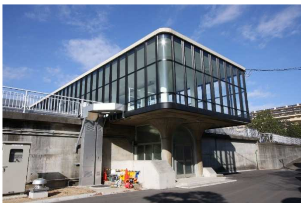
図 39 長沢浄水場操作廊終端部
