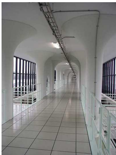
図 37 長沢浄水場操作廊
