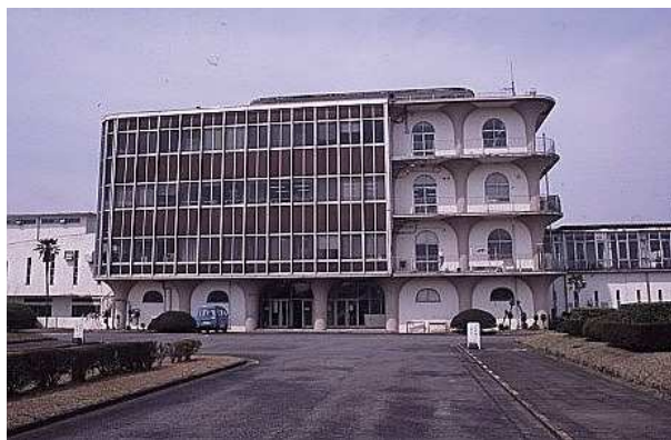
図 38 長沢浄水場管理棟(改修前)
