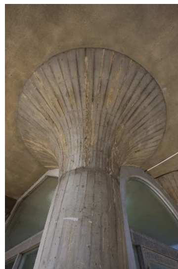
図 40 長沢浄水場コラム型枠
