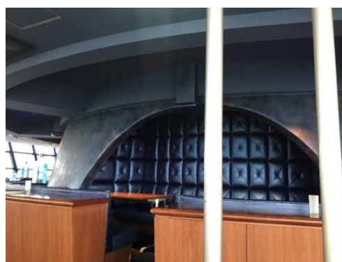
図 46 京都タワー塔体脚部にみられるパラボラ
